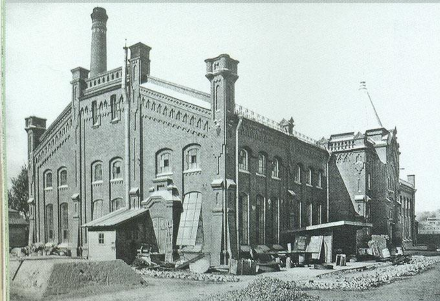
Насосная станция у Новоспасского моста. Конец XIX в.
