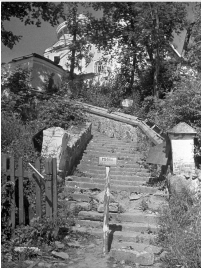
Разрушенная и заминированная захватчиками лестница к могиле Пушкина. Фото: Галина Санько
