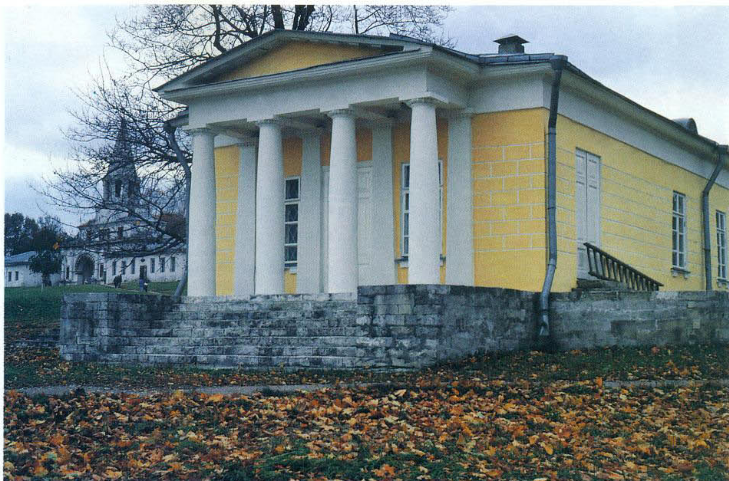
Павильон 1825 г. Архитектор Е. Д. Тюрин.
