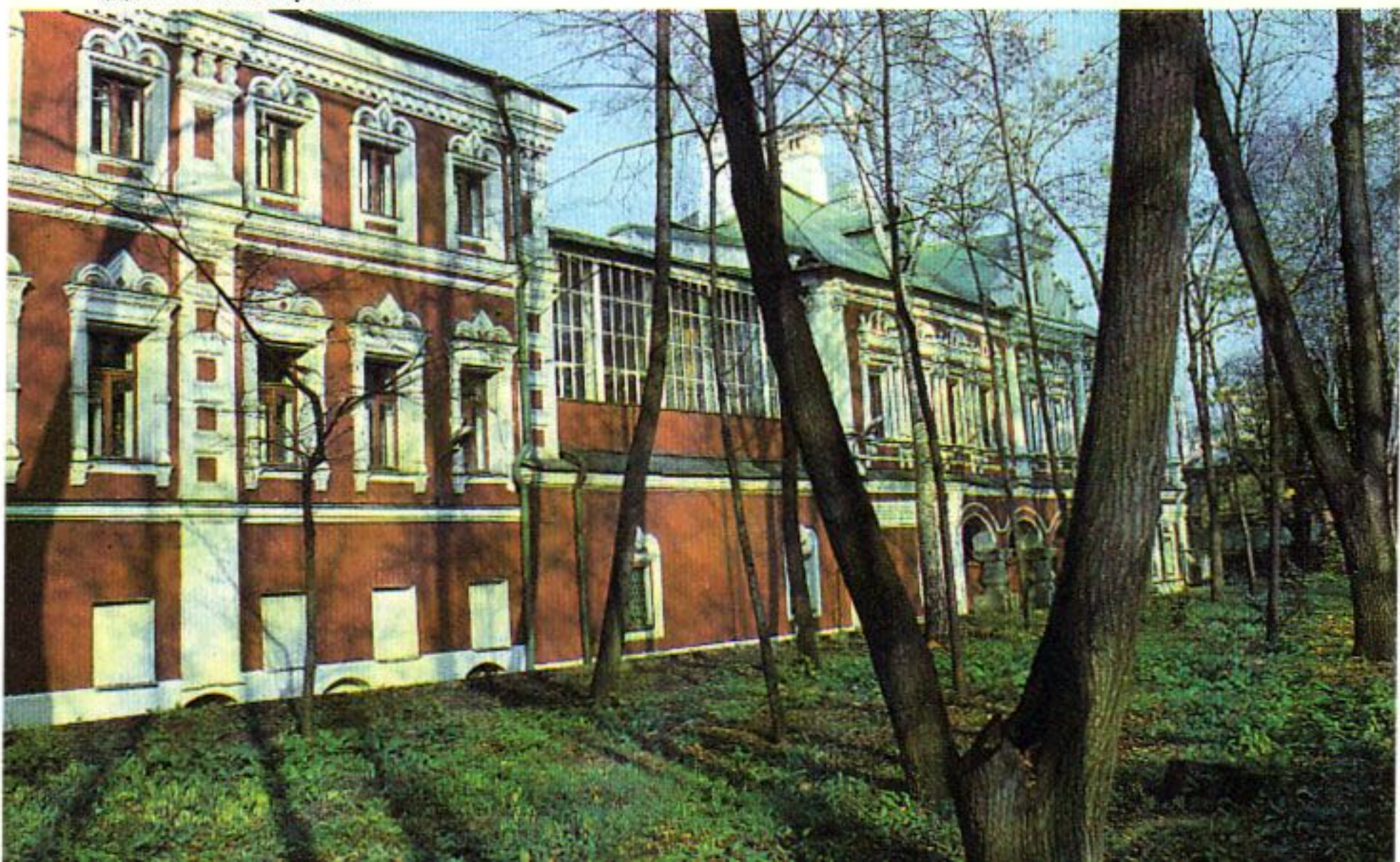
Большой Харитоньевский переулок, 21. Дом Н. Б. Юсупова
